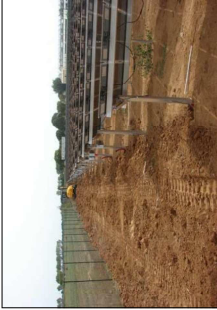
Illustration 159 : Récouvrement des tranchées
